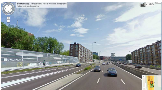
Figuur 2: Situatie A10 West ter hoogte van de Witzanghlaan (ter hoogte van de linkerflats bevindt zicht het meet en rekenpunt uit figuur 1.
